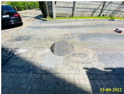
บ่อสุดท้ายก่อนระบายน้ำออก ภาพที่ 1.3.5-1 ระบบระบายน้ำและป้องกันน้ำท่วม
