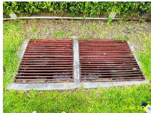
บ่อสุดท้ายก่อนระบายน้ำออก ภาพที่ 1.3.5-1 ระบบระบายน้ำและป้องกันน้ำท่วม
