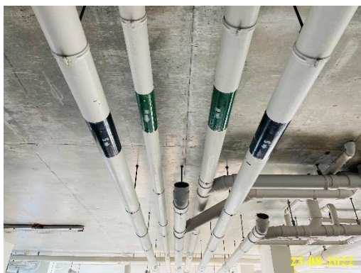
ภาพที่ 1.3.4-1 ระบบรวบรวมน้ำเสียและสิ่งปฏิกูลภายในอาคาร
